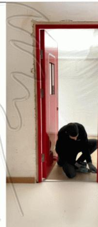
Para terminar apretaremos por completo todos los tornillos y retiraremos el Ypop, y comprobaremos el correcto funcionamiento de la Yolodoor y su cerradura.
